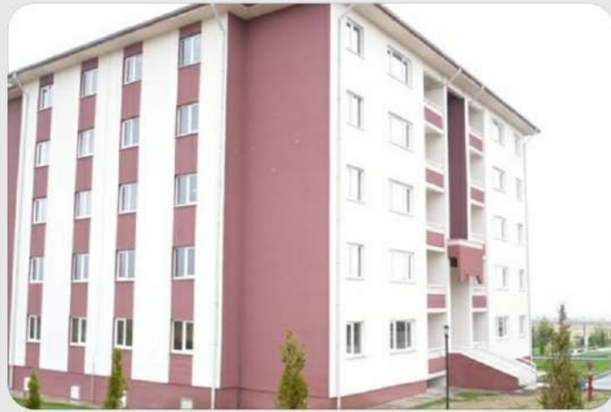
Lice-Ergani HAİT ve misafirhane (inşaatı kalıp-beton-demir işleri)
